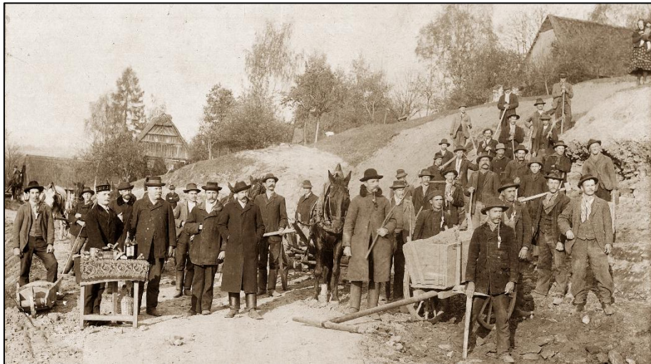
Budování silnice v Peřimově pod čp. 51 na podzim roku 1908, k tématu podrobně na poslední straně. Foto Bedřich Sieber, Jilemnice, oříznuo, originál M. Jiříšta
