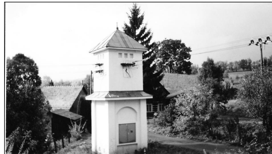
Nově opravená trafostanice
