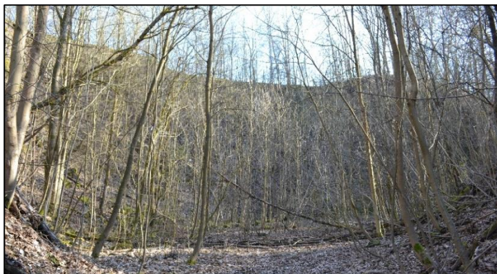
Zarostlý a opuštěný Müllerův lom. Po vytěžení mnoha tisíc kubíků kvalitního melafyru má v některých místech těžební stěna výšku 32 m.
